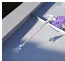
Pulverizați cu echipament de pulverizare la presiune înaltă (2 straturi).
