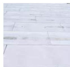
Uscarea stratului anticoroziv durează aproximativ 4-5 ore.
