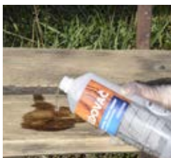
Aplicați agentul de învioreare a lemnului (turnare, pulverizare).
