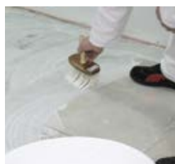
Efectuați penetrarea suprafeței cu ROKOGRUND PROFI, ROKOLATEX PLUS sau amorsă epoxidică presărată cu nisip silicios.
