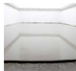
Lăsați suprafața să se întărească 4-6 ore înainte de a călca pe ea.
