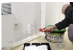
Amorsa ROKOANTIBAC are rolul de a proteja suprafața de uscare între straturi este de aproximativ 2-4 ore.
