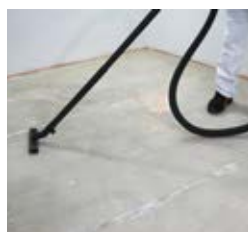
Măturați și aspirați pardoseala.
