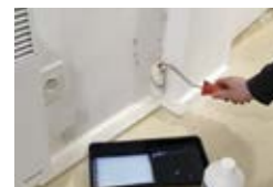
Aplicați amorsa pe perete și lăsați-o să se usuce cel puțin 8 ore.
