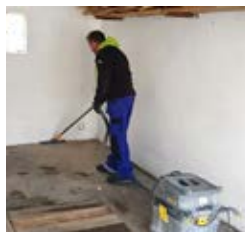
Curățați fisurile din beton și aspirați suprafața.
