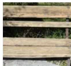
Lăsați suprafața să se usuce (optimal în soare). Aplicați uleiul de protecție sau uleiul de protecție. Lăsați să acționeze 15-30 de minute.
