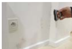
Lăsați să se usuce cel puțin 24 de ore și îndepărtați mușcariul cu o perie.
