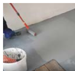
Finisați pardoseala prin tehnica straturilor încrucișate.
