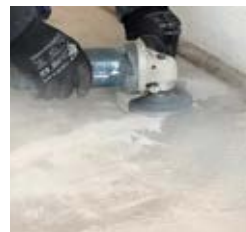
După uscare, șlefuiți suprafața cu o mașină orbitală sau un polizor unghiular.
