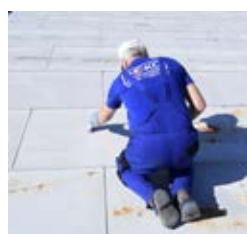
Suprafața tratată după aplicarea stratului anticoroziv.
